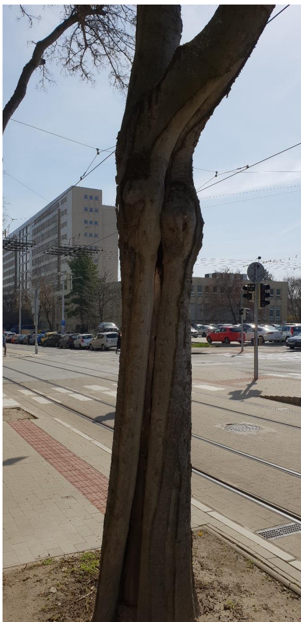
detail poškodenia kmeňa
